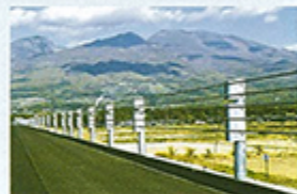
ガードケーブル Cable guardrail
