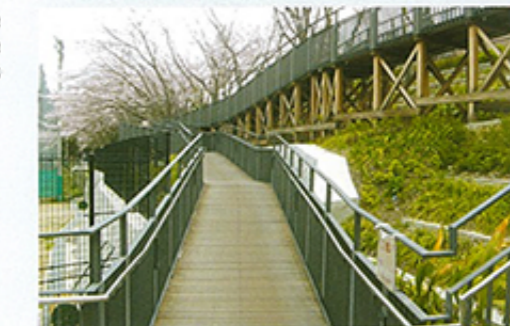
遊歩道手すり Promenade railings
