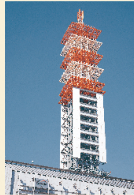
▲ 移動体通信鉄塔
